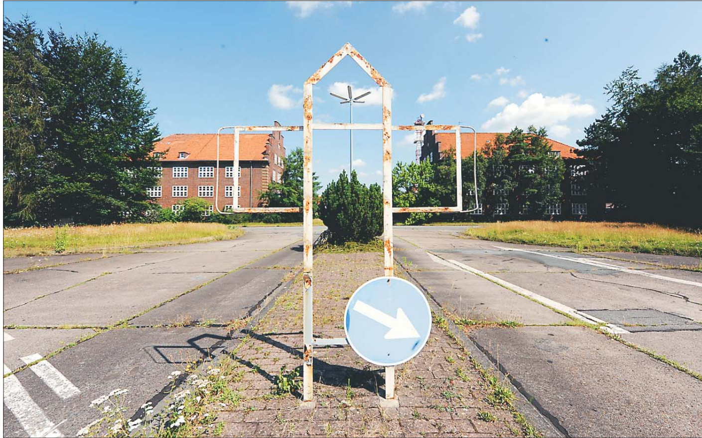
Marktfähig: Der Bund möchte bei der Donnerschwee Kaserne selbst und kurzfristig aktiv werden.
