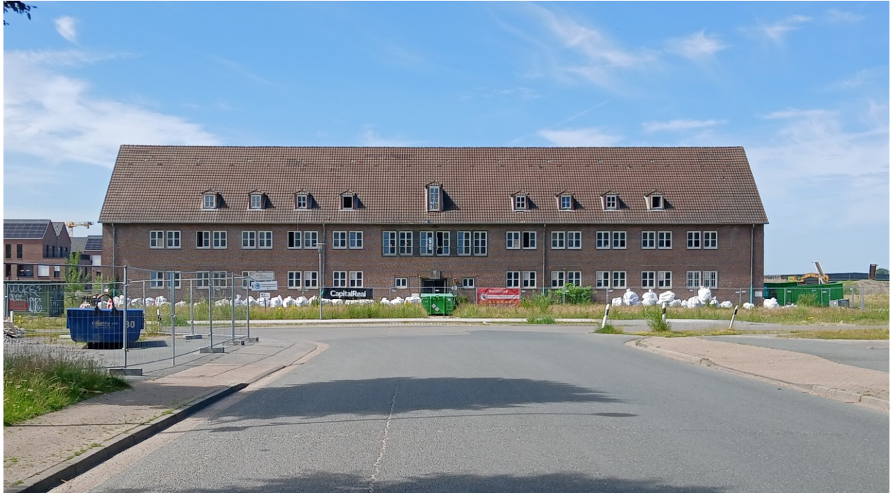
Das alte Stabsgebäude, heute. In den Plastiksäcken ist der abgeschlagene Putz aus dem Räumen. Heute Sondermüll, weil die Ausdünstungen der alten Wandfarbe angeblich gesundheitsgefährdend sind !
